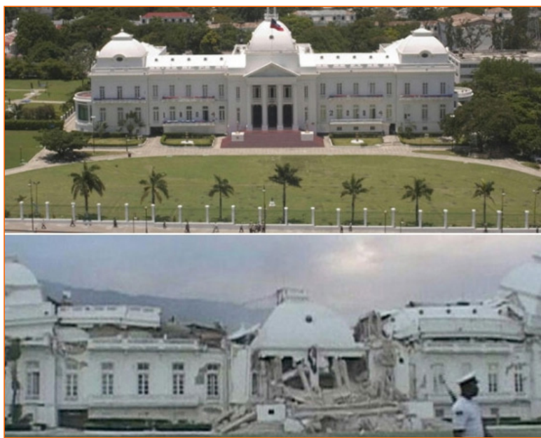
Figura 9 Il palazzo presidenziale prima e dopo il terremoto.
